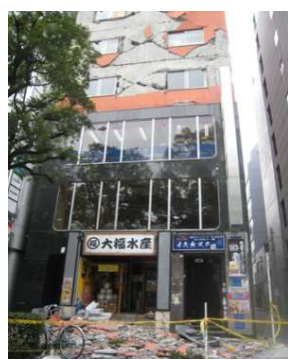
外装材・内装材の剥落発生による二次災害
